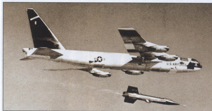
Запуск экспериментального ракетоплана X-15 с бомбардировщика B-52
